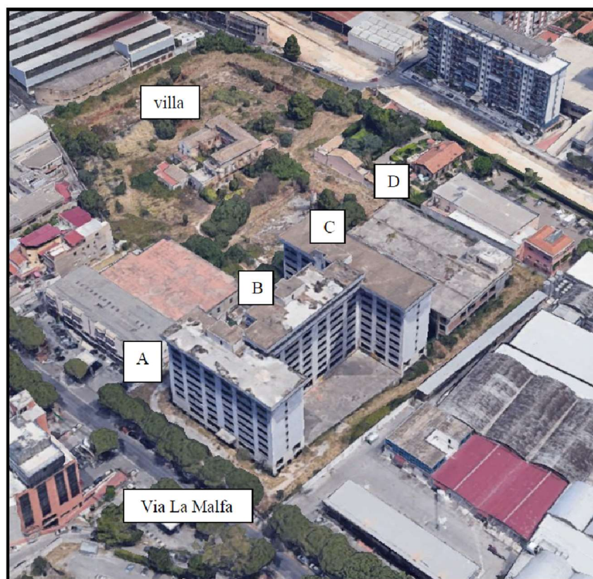
Figura 8 - Nucleo principale di 3 corpi A B C comunicanti, avente forma planimetrica ad H, costituito da 2 stecche da 9 elevazioni fuori terra e la parte centrale con 10 elevazioni fuori terra, oltre il piano cantinato, che risulta comune a tutti e 3 i corpi.
